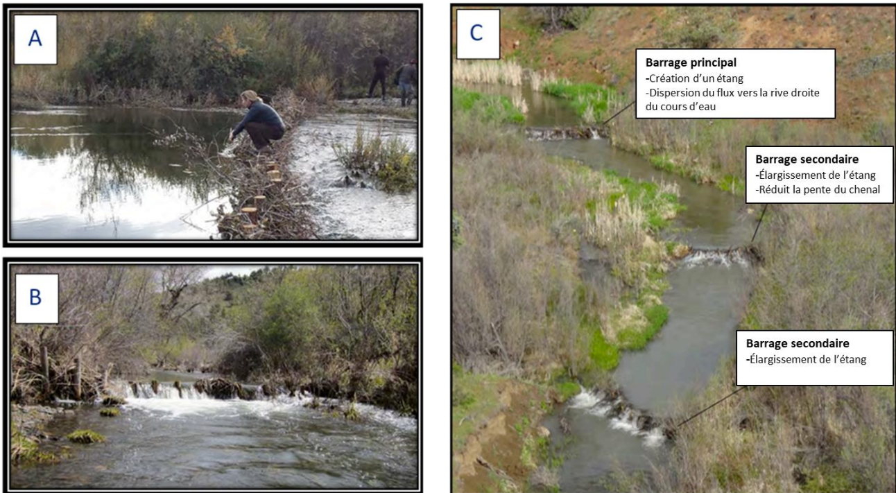
Figure 7 : A et B - Exemples de barrages de type castor (Beaver Dam Analogues) en Oregon et en Californie. C- Exemple d'une séquence de barrages de type castor (BDAs) dans le ruisseau Bridge Creek en Oregon. Source : traduit de Pollock et Castro, 2023.
