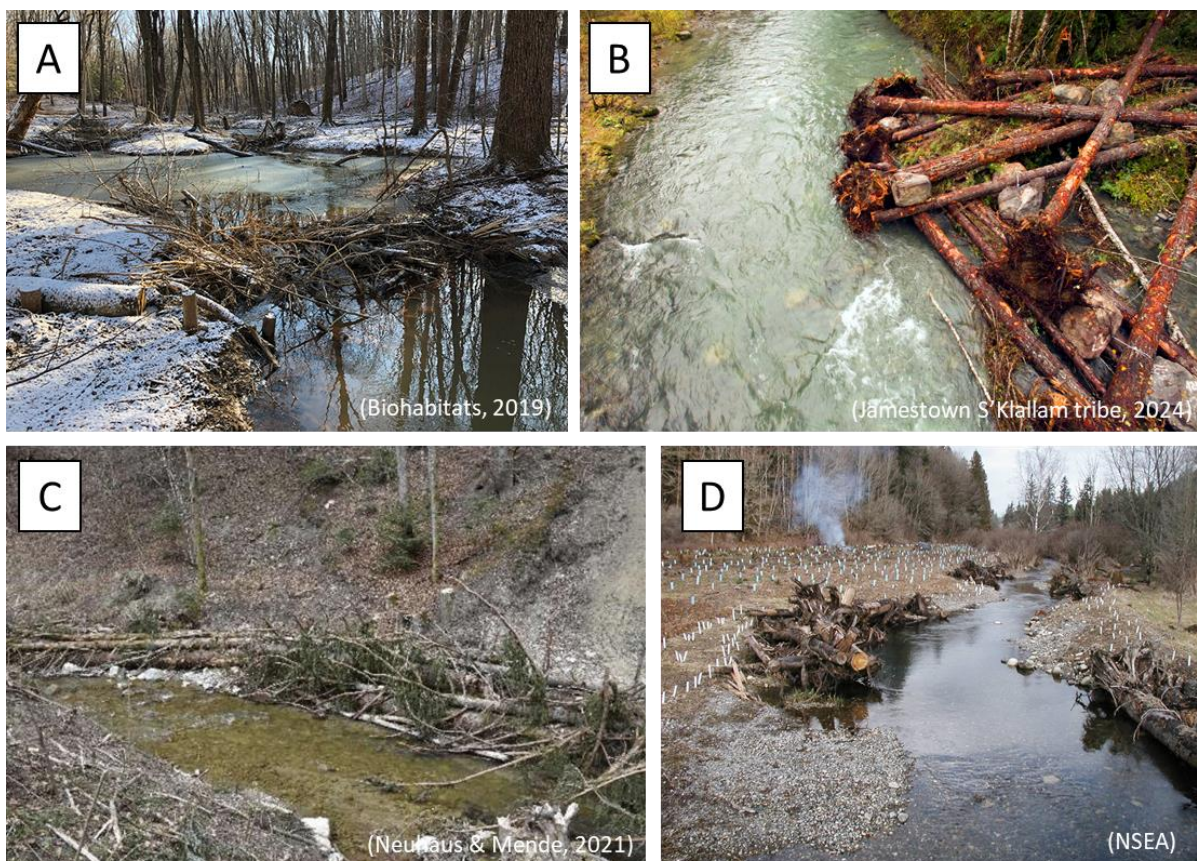
Figure 5 : A- Embâcle de bois aménagé afin d'améliorer la connectivité d'un cours d'eau dégradé du Maryland avec sa plaine inondable (Nelson 2019). B- Aménagement d'embâcle dans un contexte où la forêt est à un stade trop précoce pour assurer un recrutement naturel dans un cours d'eau dégradé de l'état de Washington, pour améliorer l'habitat des salmonidés (Jamestown S'Klallam Tribe 2024). C- Aménagement d'une structure composée de grands troncs d'arbres positionné parallèlement à un cours d'eau en Suisse afin de stabiliser la berge (Neuhaus et Mende 2021). D- Restauration complète d'un cours d'eau dégradé avec une combinaison d'actions, dont l'aménagement de bois mort sous forme d'embâcles latéraux et de végétalisation de la plaine inondable aux États-Unis (Nooksack Salmon Enhancement Association (NSEA)).
